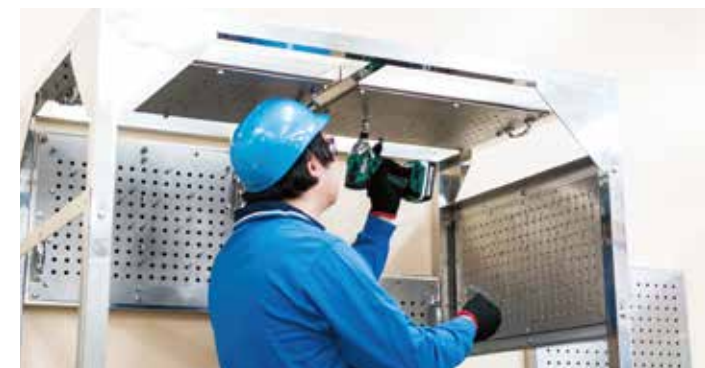
インパクトドライバーを用いたボルトの締め付け研修
